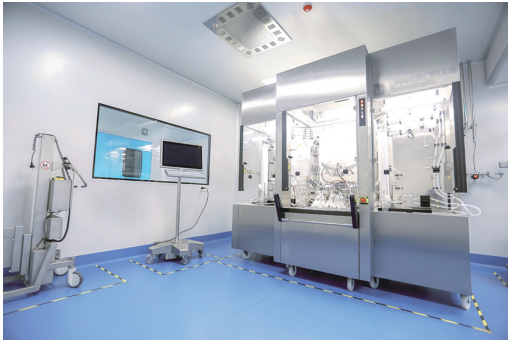
GMP 製造サイトの一例
