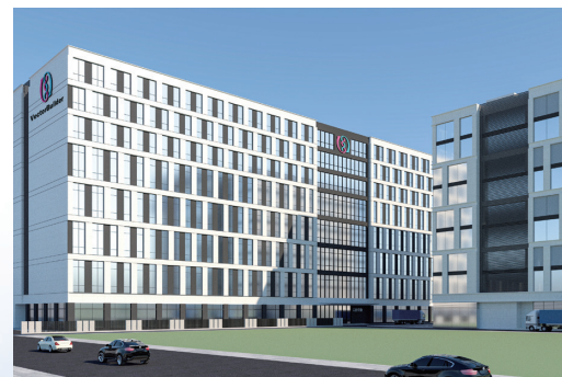
増設中の遺伝子デリバリー研究製造キャンパス 2024-2025 年に稼働予定
